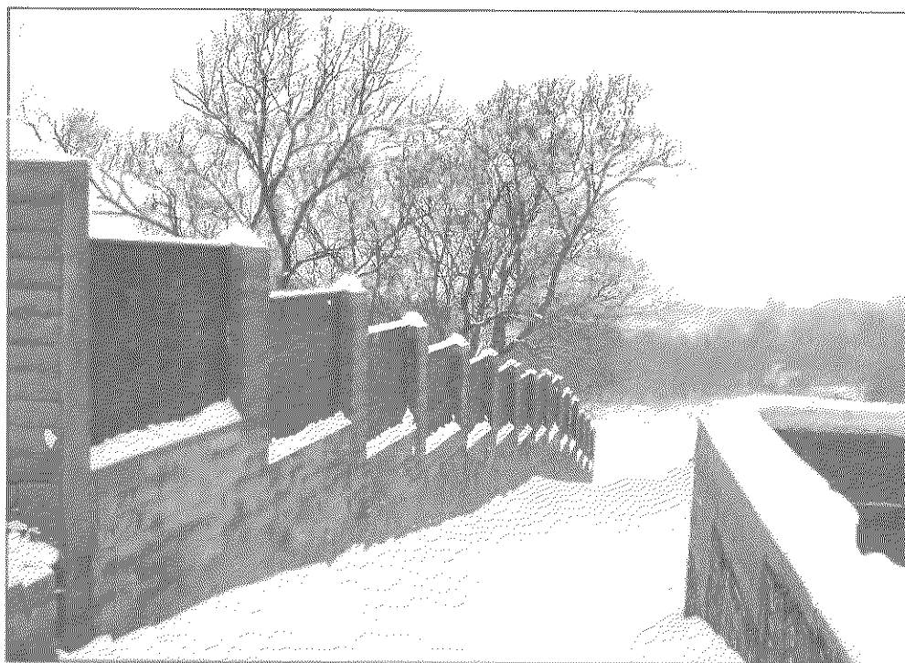
Ограждение на крутом склоне выполнено с использованием опалубки ТИСЭ-2
