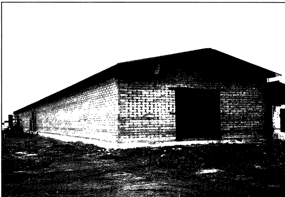
Производственный цех 70x9 м под Зеленоградом (Подмосковье) возведен с пятью опалубками ТИСЭ-3 за один месяц
