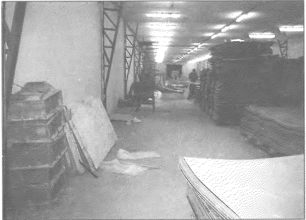
Вертикальные свесы ферменного перекрытия обеспечивают стенам здания цеха боковую устойчивость
