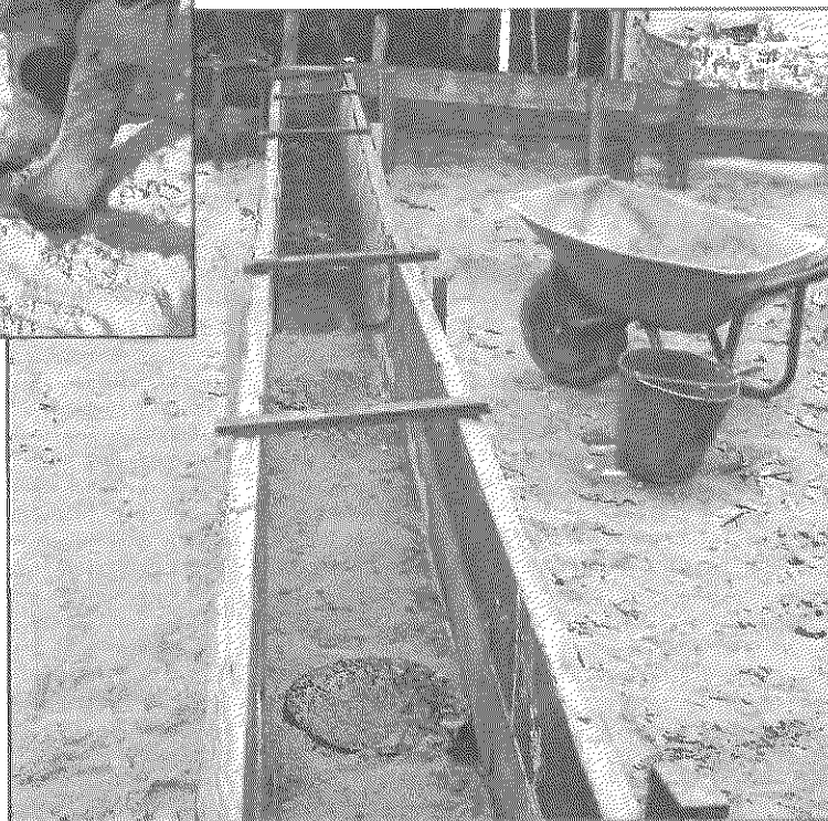
Перед заполнением опалубки бетоном на песчаную подсыпку укладывается гидроизоляция (пергамин)
