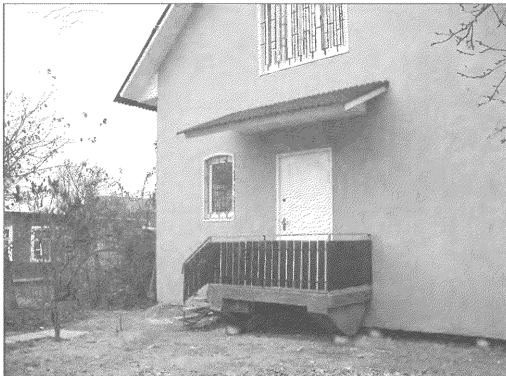
Железобетонное крыльцо опирается на заглубленные опоры, как и сам дом
