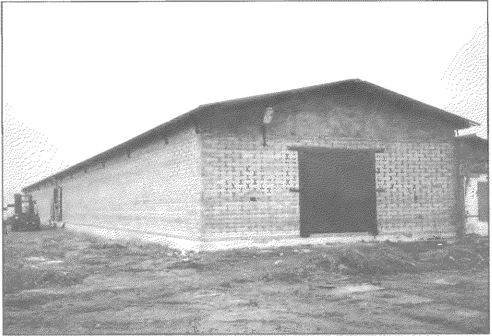
Производственный цех 70x9 м под Зеленоградом (Подмосковье) возведен с пятью опалубками ТИСЭ-3 за один месяц
